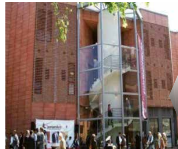
Galleria Mercato Ponte Milvio, Roma 6 impianti MRL, gearless 1 m/s, 1.000 Kg. geared 1 m/s 630 Kg. - gearless 1 m/s 900 Kg panoramico Gallery Market Ponte Milvio, Roma 6 lifts MRL, gearless 1 m/s, 1.000 Kg. geared 1 m/s 630 Kg. - gearless 1 m/s 900 Kg panoramic
